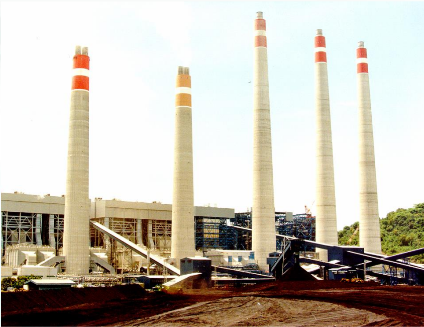
Coal Yard PLTU Suralaya 4 x 400 MW dan 3 x 600 MW di Jawa Barat dimana tampak Conveyor Pengangkut Batu Bara dan Cerobong.
