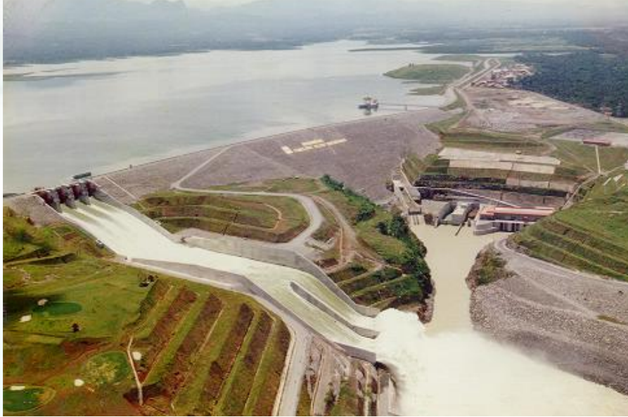
Bendungan PLTA Mrica di Jawa Tengah dengan kapasitas 3 x 60,3 MW dimana tampak Bendungan beserta Pelimpasannya (sisi kiri) dan Gedung PLTA beserta Air Keluarnya (sisi kanan).
