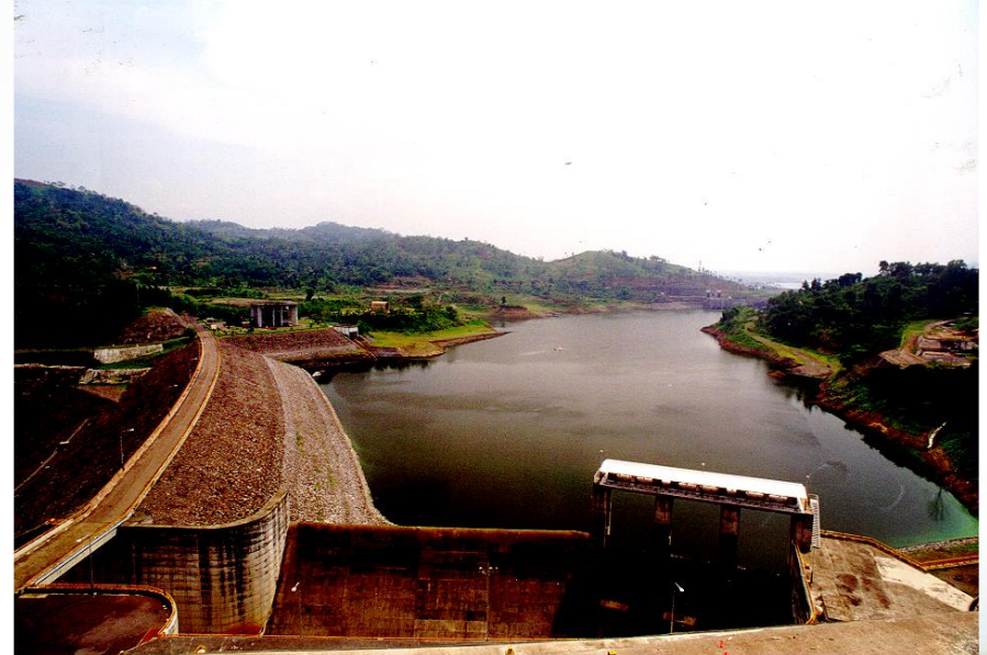
Bendungan Waduk PLTA Saguling 4 x 175 MW dimana tampak Rock Fill Dam (sisi kiri) dan Pelimpasan (bagian tengah) serta Pintu Air untuk pengamanan Dam.
