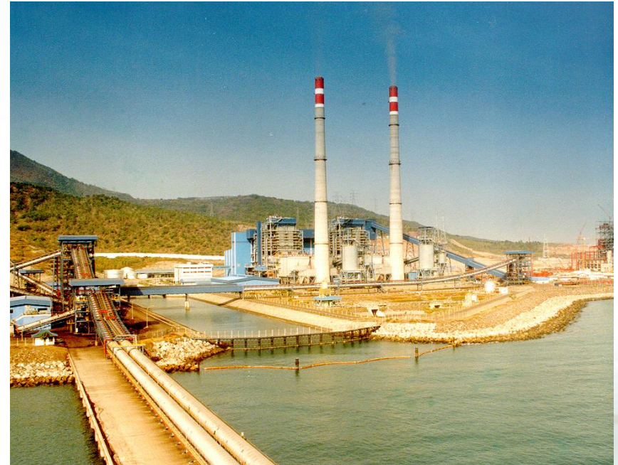
PLTU Paiton milik PLN 2 x 400 MW di Jawa Timur dimana tampak Intake Air, Conveyor Batu Bara, Ketel Uap, dan Cerobong.
